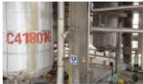
近日,己内酰胺公司双氧水装置纯化系统改造项目顺利完成施工。双氧水装置纯化系统原有两组三台并联的吸附塔,一组用于吸附操作,另一组用于再生操作。根据树脂吸附状况及装置生产能级,在原有基础上,增加了两台吸附塔,以保证适宜的操作周期,同时增加了一台双氧水冷却器,以降低双氧水的吸附温度,提高吸附性能。该项目的实施将大幅度提高双氧水装置纯化系统产能。(康乐书)
