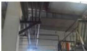
为解决生产运行中气压管道内铁锈、铁渣易把网络丝嘴堵住,产生断网与网点不牢问题,化纤公司四车间与公用工程联合协作,利用停机时间对车间内三条主力气压管道进行爆管,使气压管道内的铁锈、铁渣在巨大的压力冲击下瞬间喷出管外,待排干净后,封闭管道末端,再进行生产送气。开机生产后,喷嘴易堵现象明显减少,DTY网络质量明显提高。(王军)
