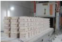
日前,针对培烧炉电阻丝易断,内部耐高温砖脱落严重等问题,己内酰胺公司氨化装置进行了一次全面整改,重点对培烧炉 X61703A/B 进行了内外部除尘、底部电阻丝更换、侧壁高温砖加固等。培烧炉是催化剂再生处理的关键设备,2014 及 2015 年随着生产负荷的提高,催化剂再生岗位任务也变得更为繁重,装置安排专人定期主动对其进行维护和整改刻不容缓。维护整改的培烧炉运行效率明显提高,培烧生产的催化剂干燥度合格,且容易打磨打包,很好地满足了生产需求。(宁春花)
